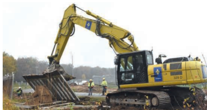
Der Abbruch beginnt – am 9. November 2017
