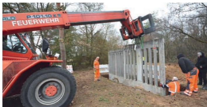
Die Mauerteile werden – am 8. März 2019 – in die Baugrube eingepasst
