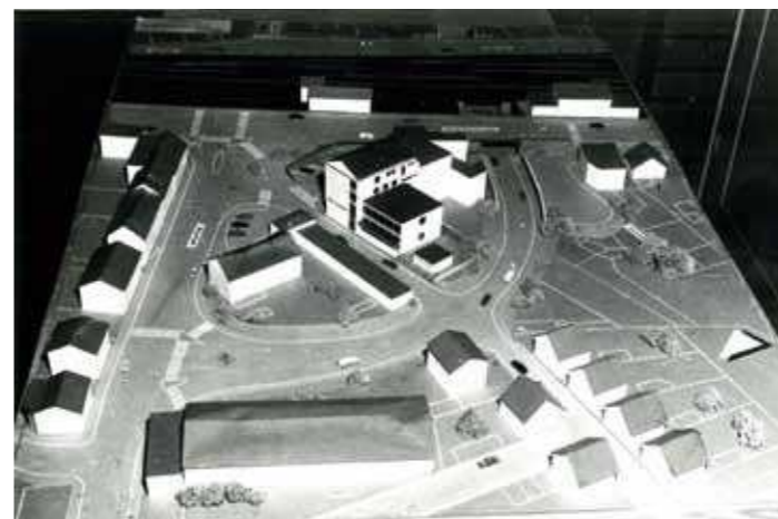
Der Entwurf für die Unterführung unter der Bahnlinie Anfang der 1960er Jahre, wurde modifiziert umgesetzt
